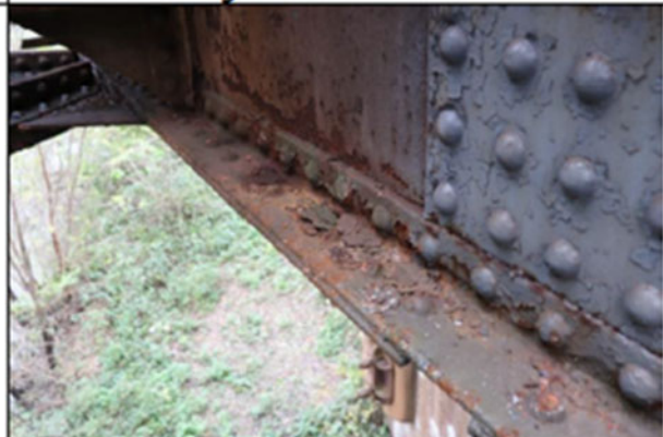
Vernice che si sfoglia dalle travi di testata
