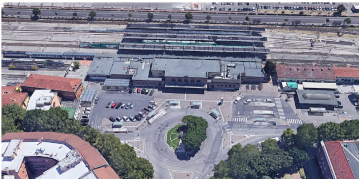
Vista d'insieme del complesso di stazione di Ravenna
