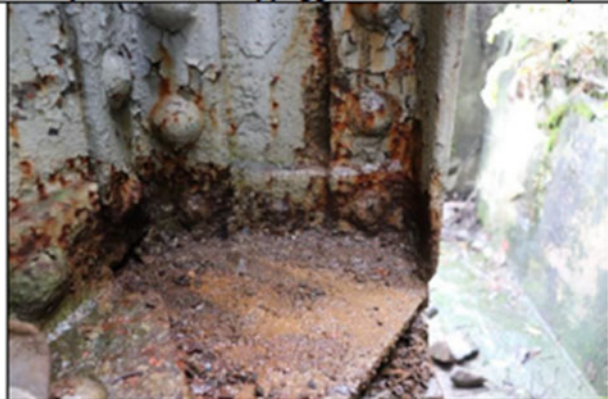
Vernice che si sfoglia dalle travi di testata
