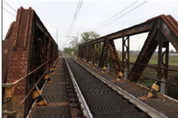
Forte ossidazione con perdita di spessore della piattabanda in prossimità dell'appoggio mobile del binario pari
