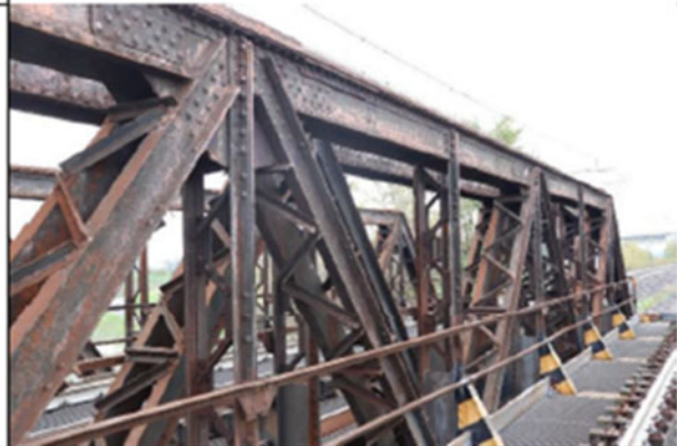
Forte ossidazione con perdita di spessore della piattabanda in prossimità dell'appoggio mobile del binario pari
