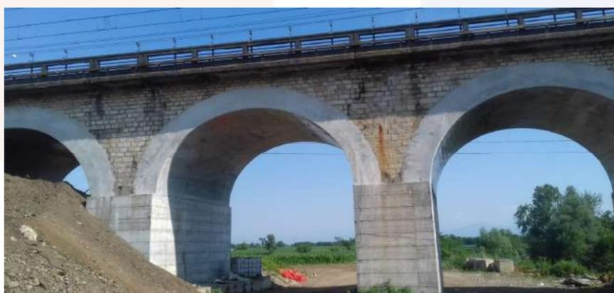
**Accordo Quadro n. 484/2017 - Contratto Applicativo n. 16/2018** – “Per l’esecuzione in appalto dei lavori di “Intervento urgente di messa in sicurezza del ponte al km 170+016 della linea MI-BO, località Secugnago, consistente nella posa di sistemi di sostegno ai binari e consolidamento del corpo stradale”.
